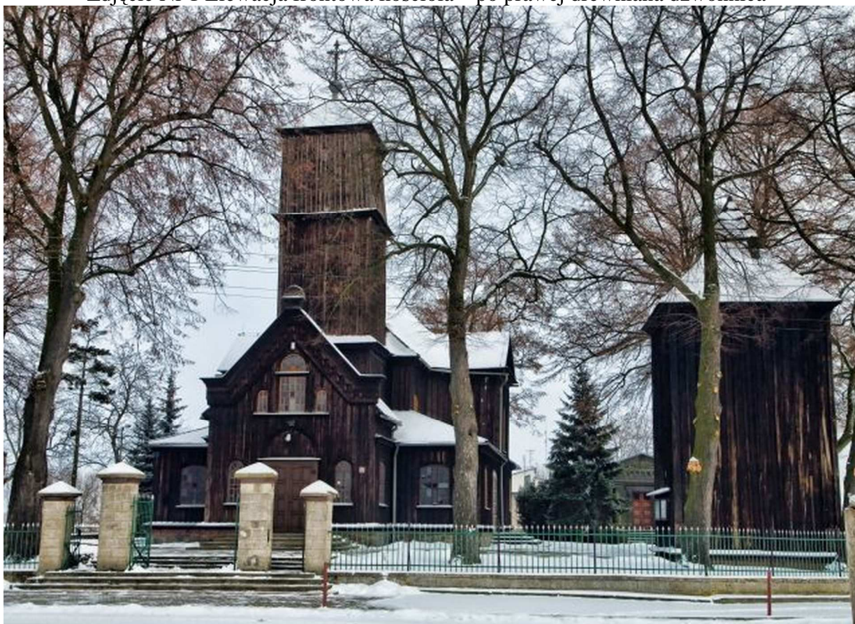
Zdjęcie Nr 1 Elewacja frontowa kościoła – po prawej drewniana dzwonnica
