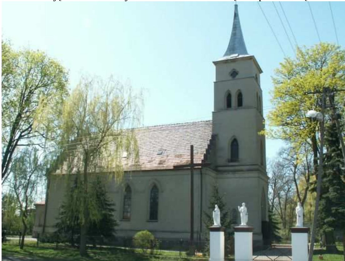
Zdjęcie Nr 2 Elewacja boczna – widok na wieżę oraz płot i bramę
